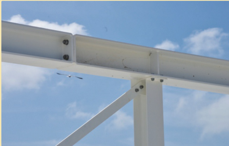
Figuur 12a Kolom-liggerverbindingen, scharnierverbinding (Bron: J.H. Jonkeren)
