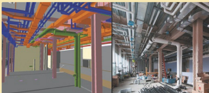
Figuur 18 BIM en hoe het er in de praktijk uit komt te zien (Bron: Lanmarservices.com)
