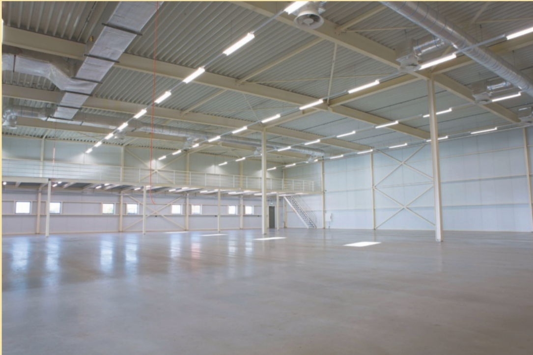
Figuur 15 Kruisvormige windverbanden in de gevels (Bron: HDK)
