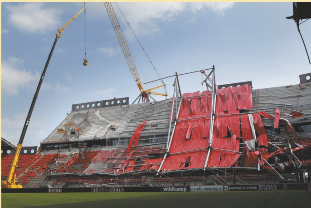
Figuur 1 Tijdens de montage ingestort tribunedak van Stadion de Grolsch Veste in Enschede (Bron: Vincent Jannink ANPfoto)
