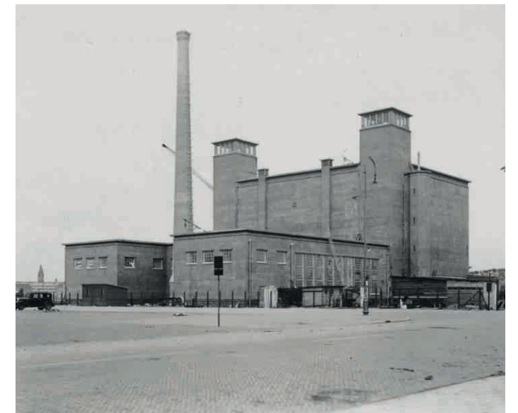
CENTRALE MARKTHAL MET TOREN
