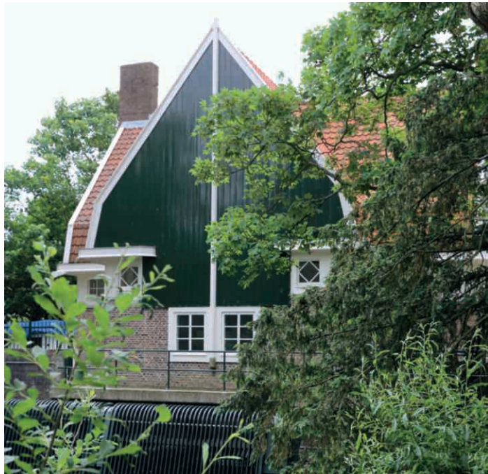
GEMAAL STADWIJCK AMSTELDIJK AREND JAN WESTERMAN AD GRIMMON • INTERIEUR GEMEENTELIJK MONUMENT 1921
