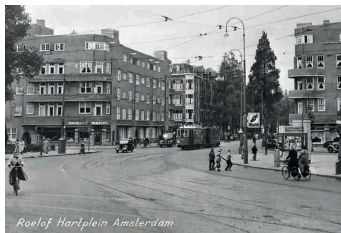
KIOSK AAN DE AMSTELDIJK, JAN DE MEIJER, 1925 KIOSK, ROELOF HARTPLEIN, NICO LANSDORP
