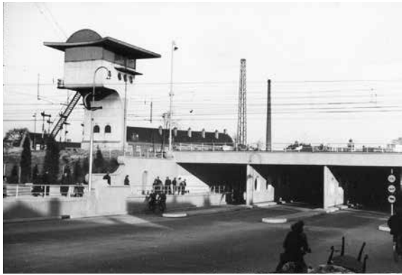
Het nieuwe spoorwegviaduct ten noorden van het station in 1938. Het nieuwe seinhuis werd ontworpen door Sybold van Ravesteyn, de architect die het station ook een nieuw ontwerp zou geven.
