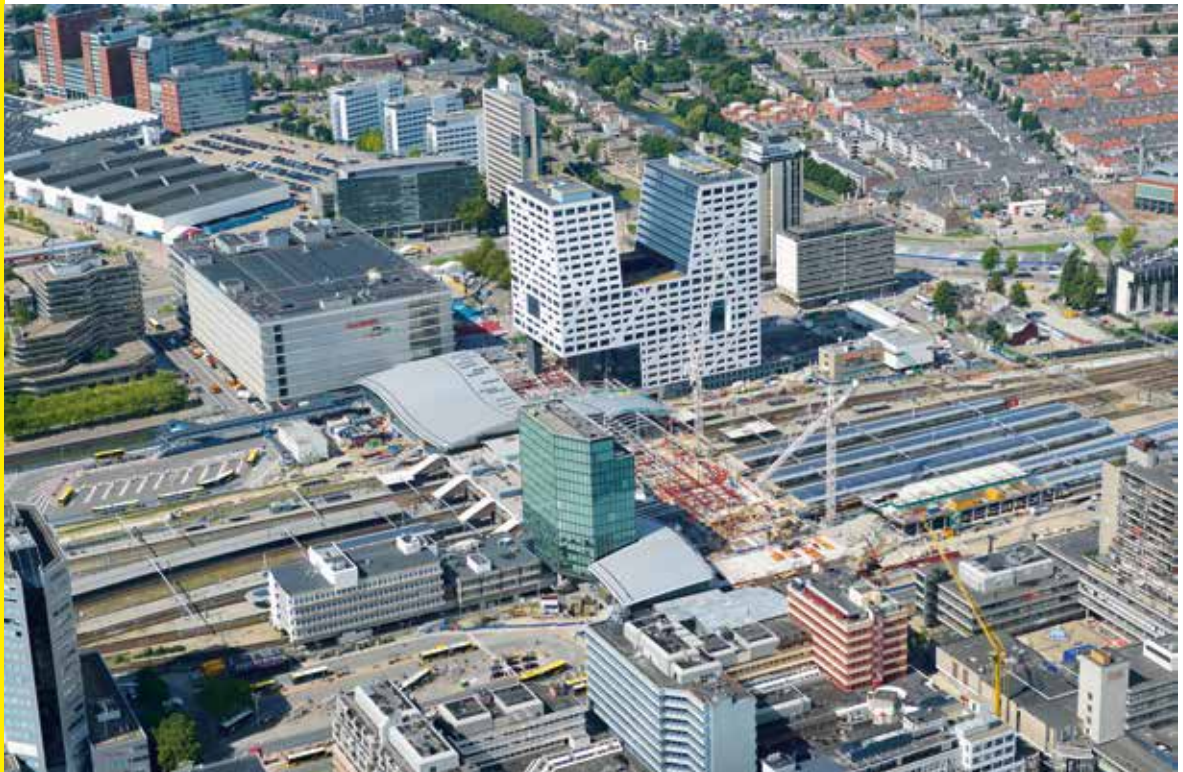
Utrecht CS en het nieuwe stadskantoor in 2014. De nieuwe Stationshal is in aanbouw.
